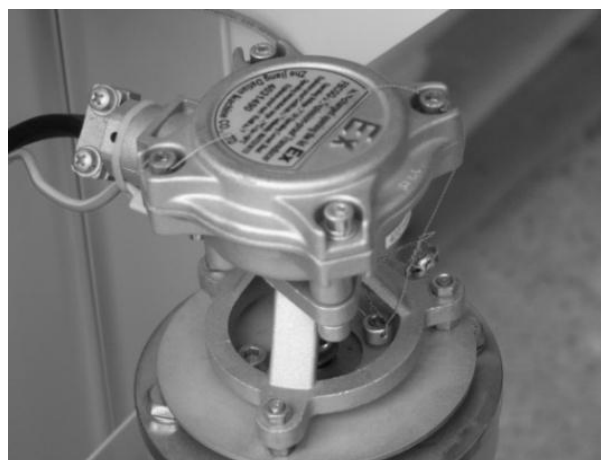
Рисунок В.3 Пломбировка генератора импульсов
